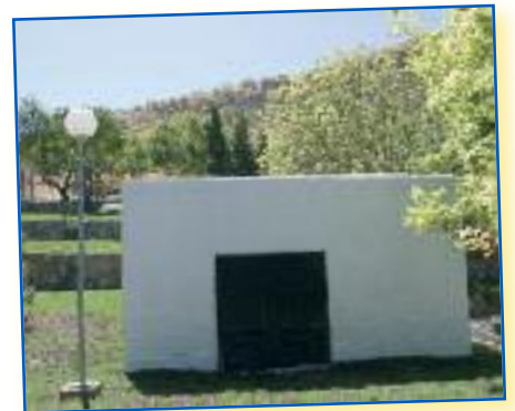
La nueva caseta de la depuradora se ajusta a la normativa vigente, que obliga a su ubicación en la superficie.
